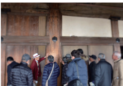
▲姫路城大柱(心柱)400年前の縦/木
